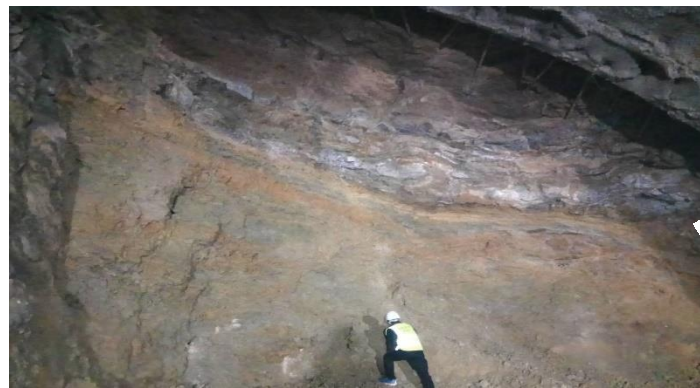
在裸露围岩下方作业
