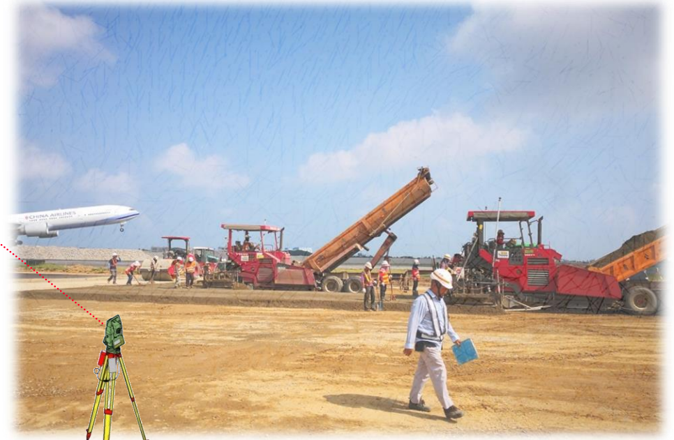
全站儀 施工檢查&交互前進 全站儀
