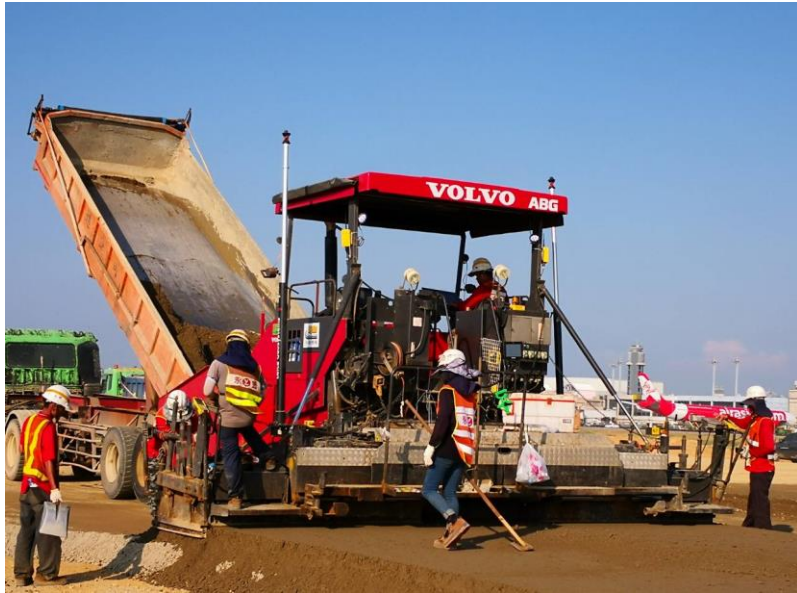
然後鋪路機按設計作業
