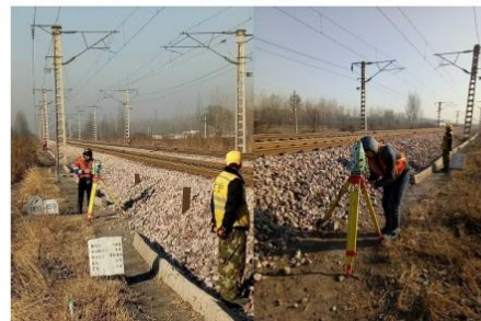
图 8.5 固定桩外业测量观测现场图
