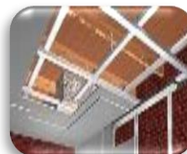
Ceiling 天花板安装
