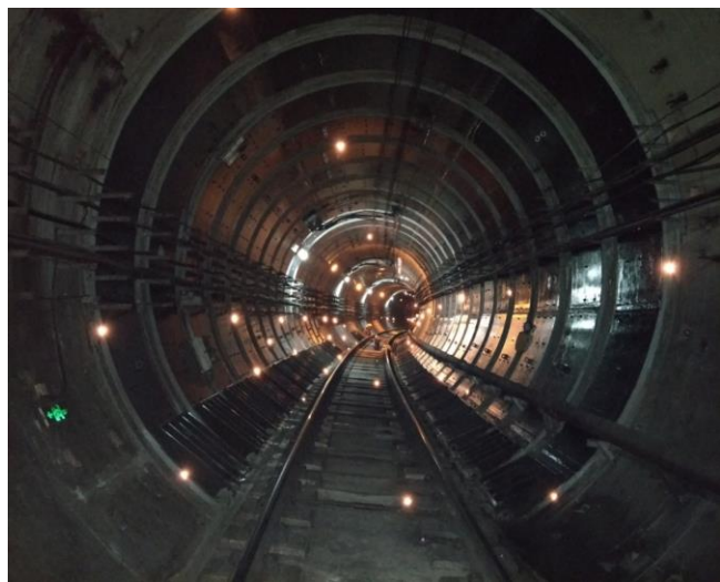
加固后现场图
