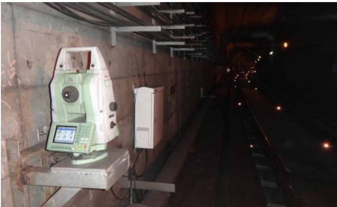
测量机器人实现地铁保护区自动化监测
