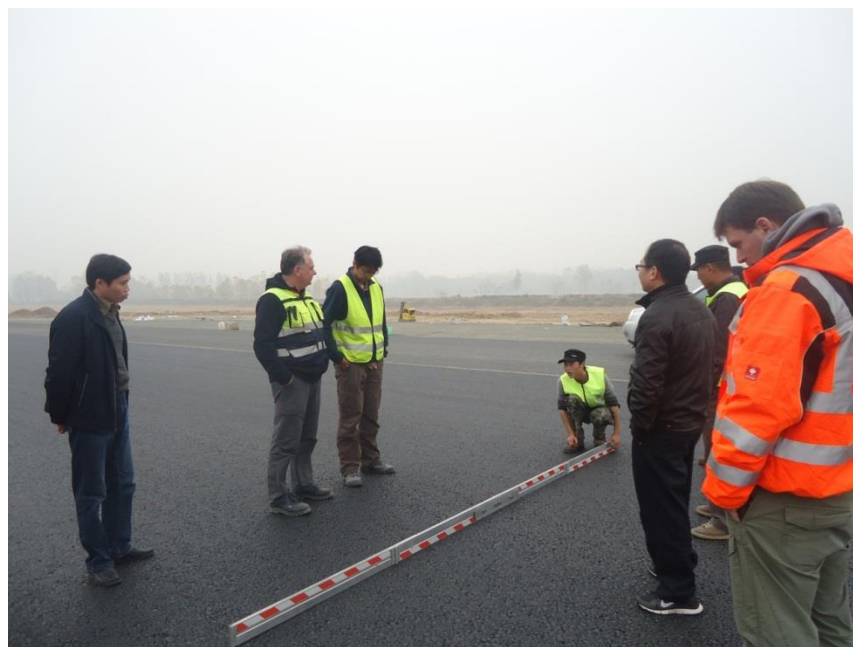
公司领导与德方专家一同现场测量博世试车场VDA区下面层平整度（4m直尺测量）
