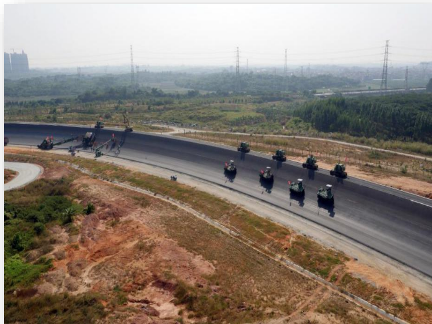
曲面沥青摊铺
