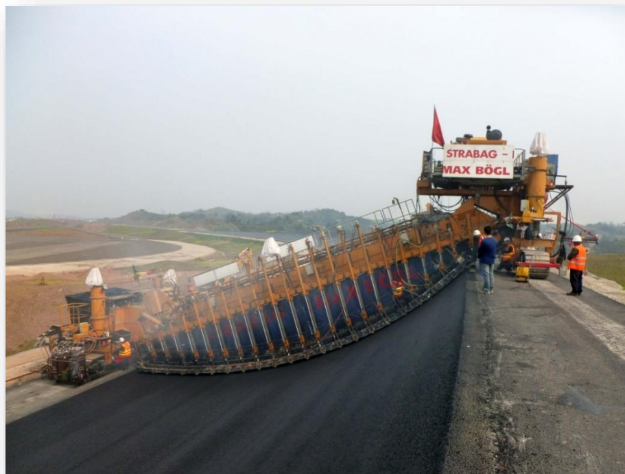
全断面摊铺机摊铺
