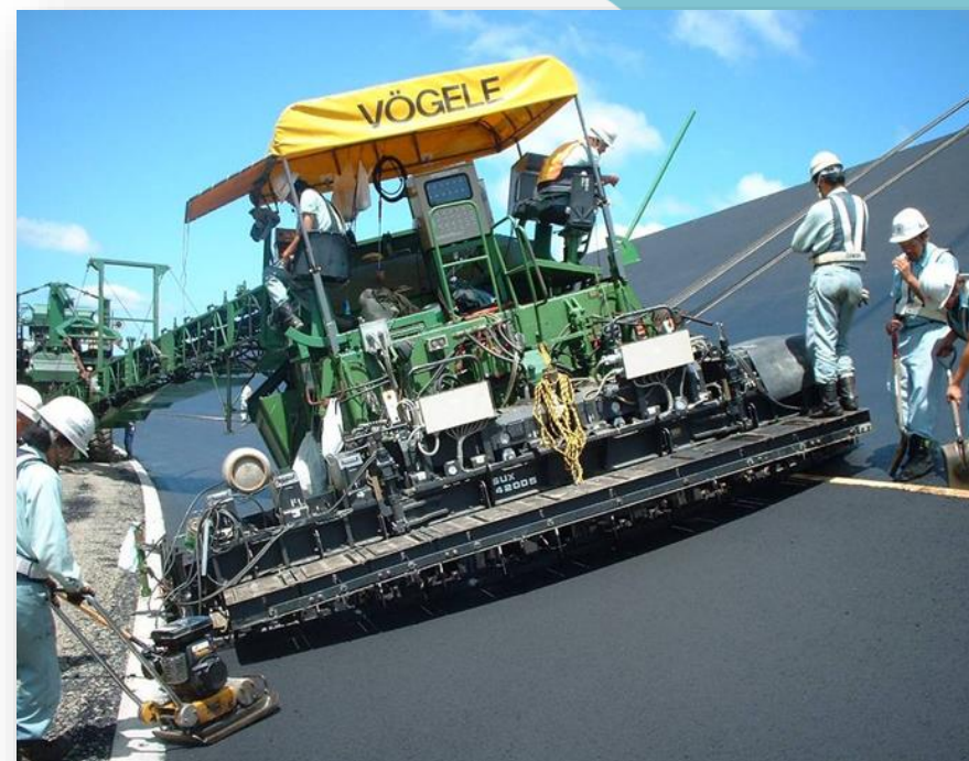
分幅分车道摊铺
