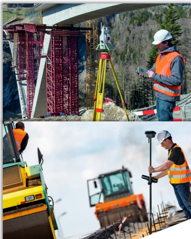
Surveying 工程测量
