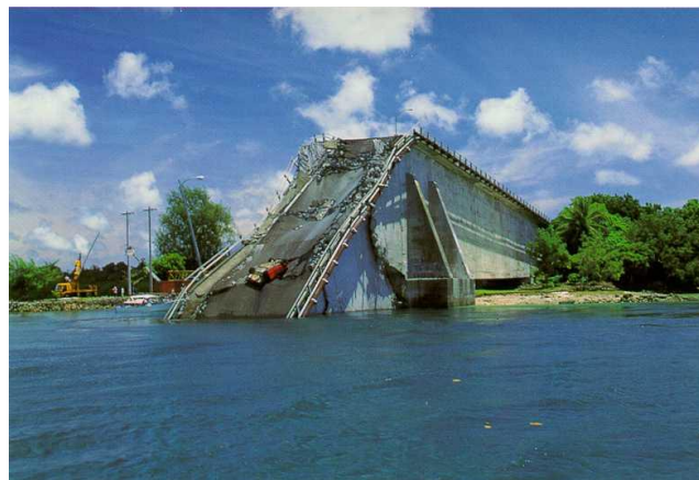
1996年，帕劳共和国的Koror-Babeldaob桥倒塌，6人伤亡。
