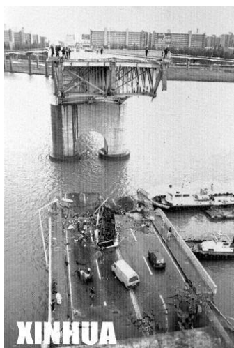
1994年韩国汉城圣水大桥断塌，死亡32人。
