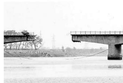
2004年，我国辽宁省盘锦辽河大桥发生悬臂梁端断裂，桥板脱落。
